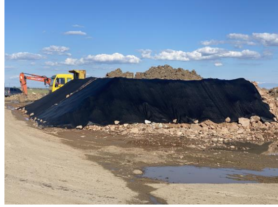
厂区临时堆土场苫盖措施
